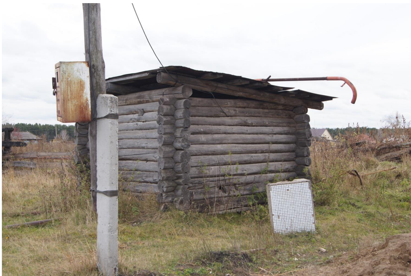
Рисунок 2.4 – Павильон скважины, расположенной на ул. Заречная
