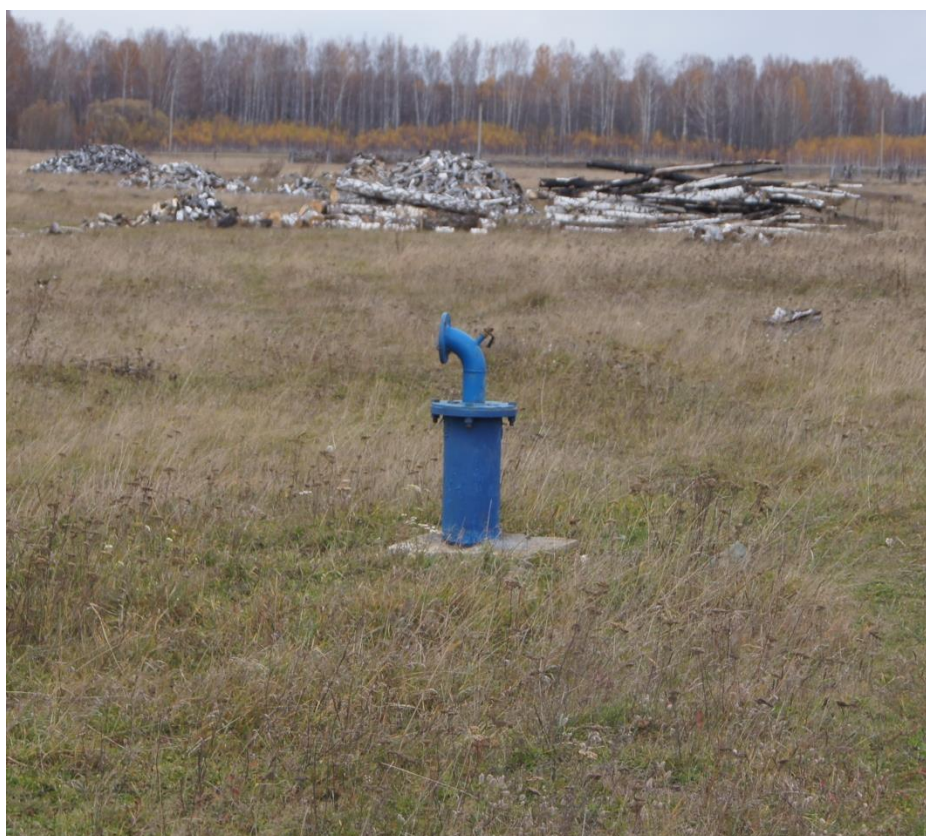
Рисунок 2.3 – Оголовок скважины, расположенной на ул. Молодежная
